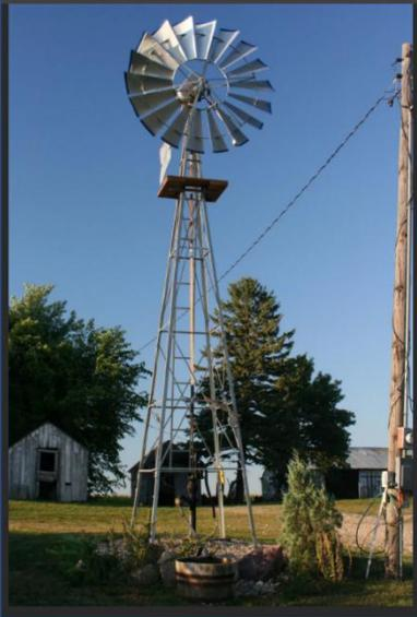
Перед вами оригинальный насос, который позволяет за счет энергии ветра поднимать воду с глубины и подавать ее потребителям, не расходуя электроэнергию. Этот агрегат называется ОНА иногда помогает рассеять сомнения. Назовите ее.
